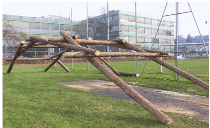
Abb. 4: Leonardo-Brücke am Schulgelände
